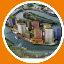
The Energy Centre, Großbritannien
