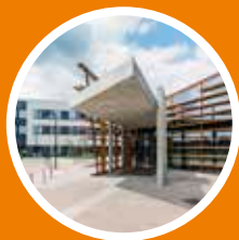
ZMK Krankenhaus, Niederlande
